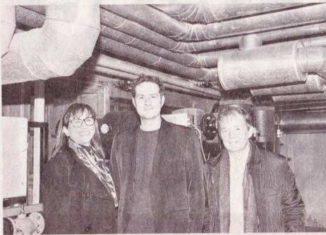
Petra Rinnenburger (v.l.) von der Gebäudewirtschaft der Stadt Köln, Schulleiter Marco Isermann und Leiter des operativen Vertriebs der RheinEnergie AG Peter Neuhaus präsentieren die neue Heizanlage des Rhein-Gymnasiums. Foto: tau
